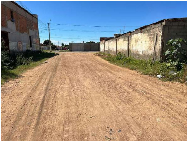
FOTO 03 – Rua 09 Quadra S17-Trecho 02
