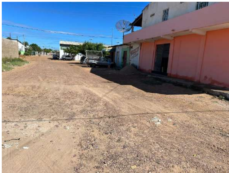
FOTO 05 – Rua 02 Quadra S17-Trecho 02
