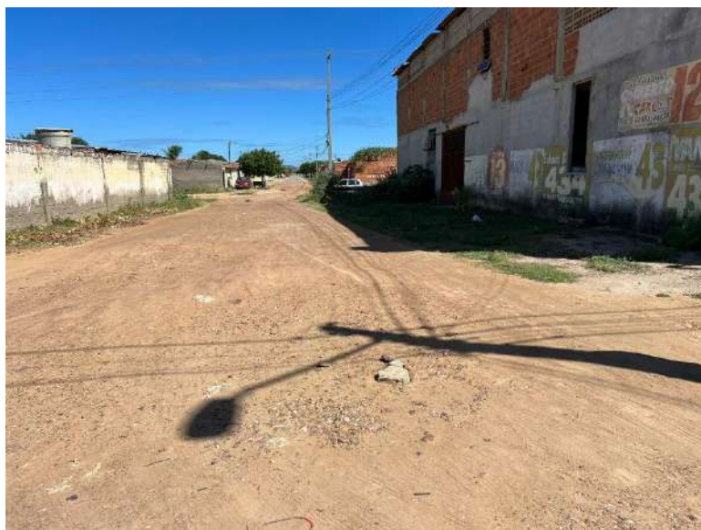
FOTO 02 – Rua 09 Quadra S17-Trecho 02
