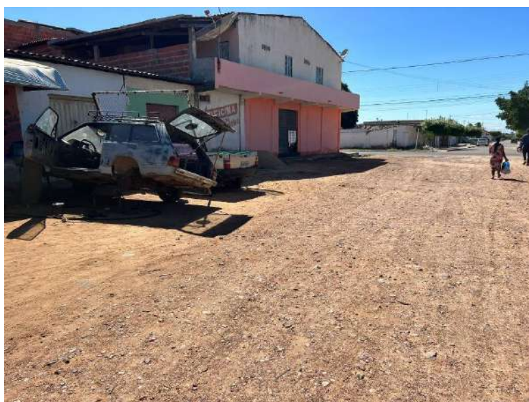
FOTO 04 – Rua 02 Quadra S17-Trecho 02
