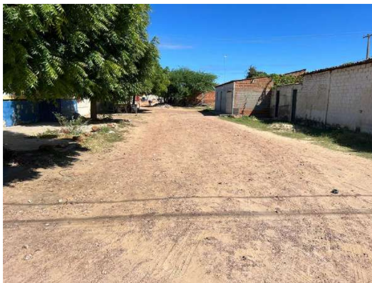
FOTO 03 – Rua 08 Quadra S17-Trecho 02
