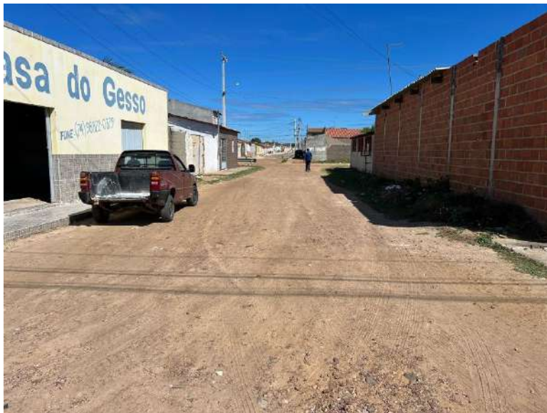
FOTO 01 – Rua 06 Quadra S17-Trecho 02
