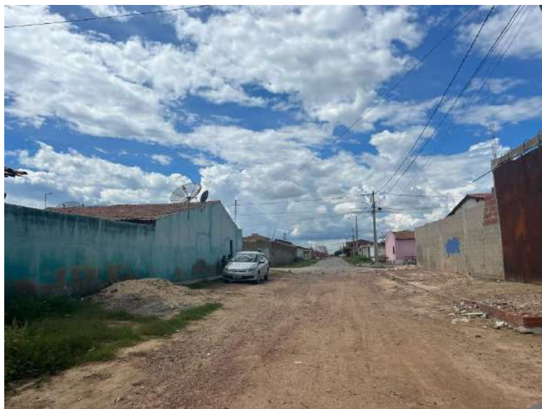
FOTO 02 – Complemento Travessa E Quadra S11/S13
