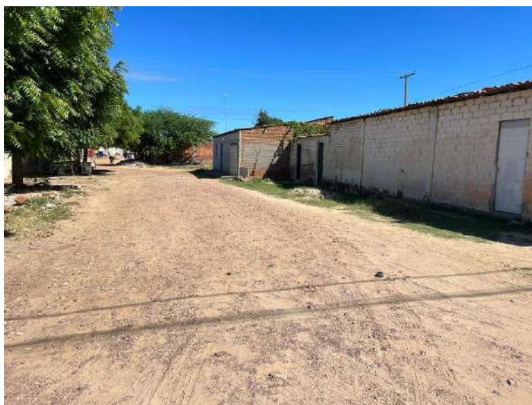
FOTO 04 – Rua 08 Quadra S17-Trecho 02
