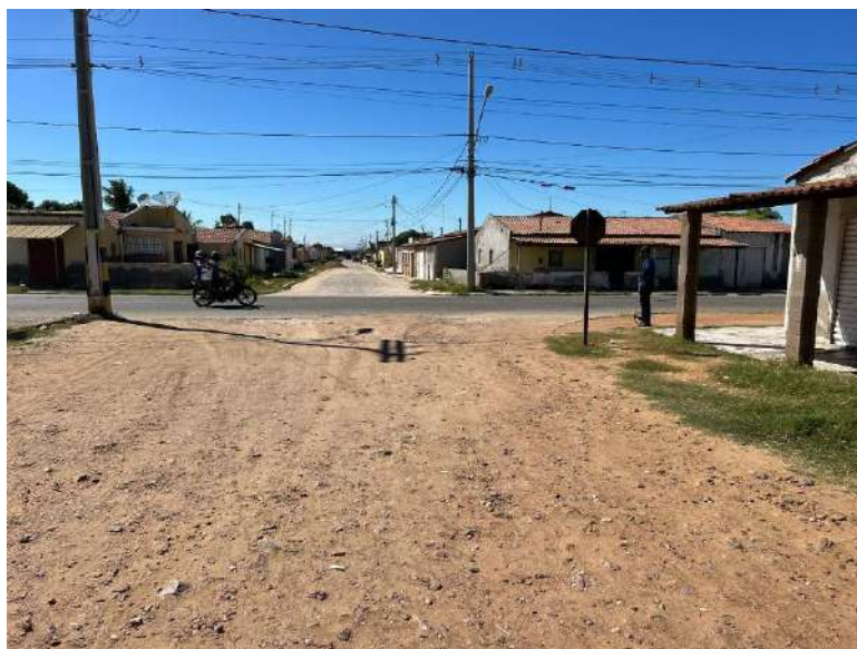
FOTO 02 – Rua 05 Quadra S17-Trecho 02
