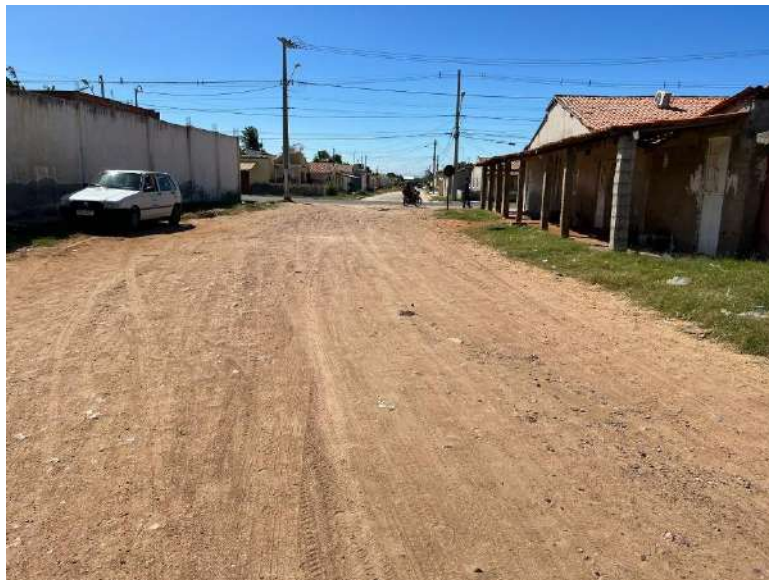
FOTO 01 – Rua 05 Quadra S17-Trecho 02
