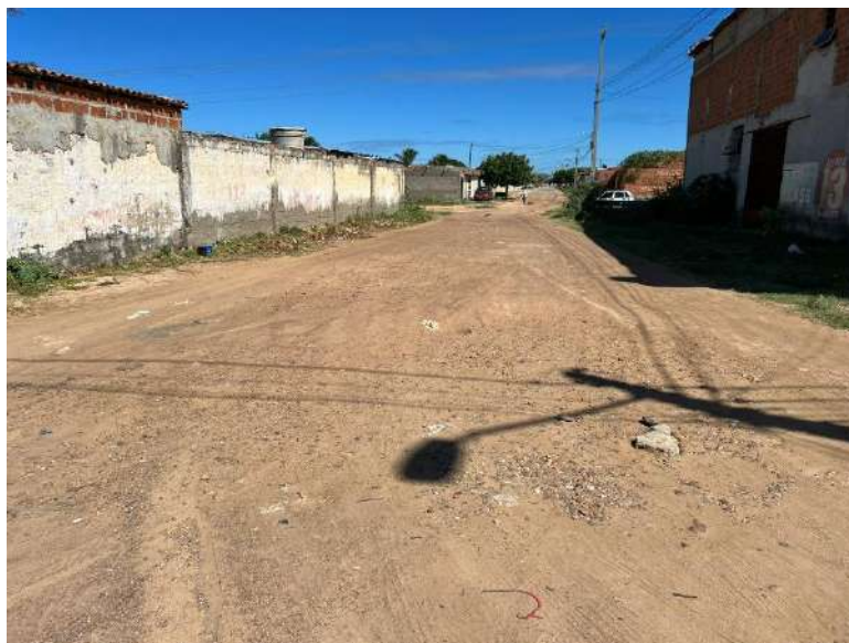
FOTO 01 – Rua 09 Quadra S17-Trecho 02
