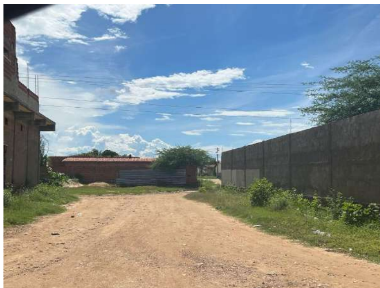
FOTO 01– Rua 11 Quadra S17-Trecho 02
