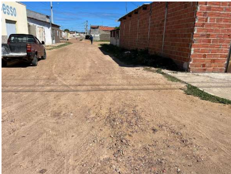
FOTO 03 – Rua 06 Quadra S17-Trecho 02
