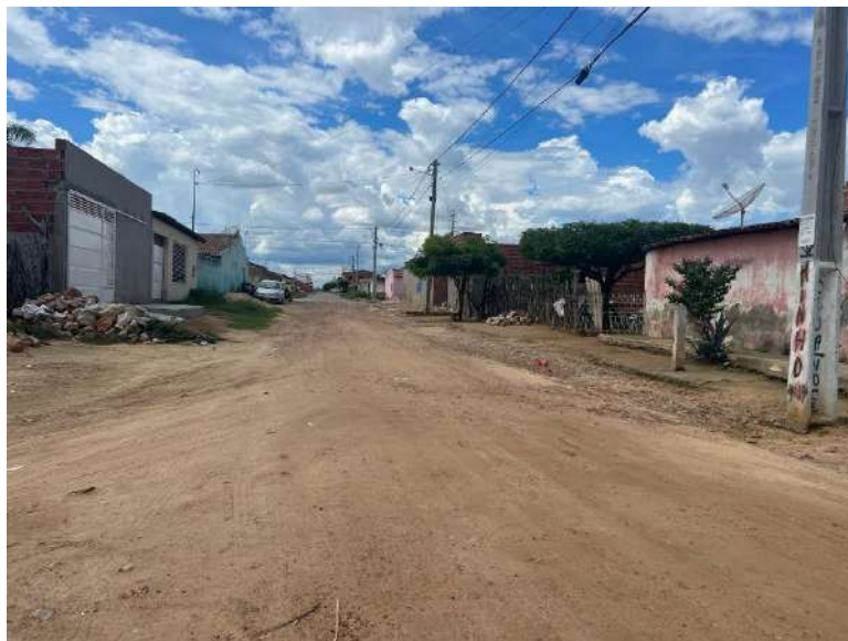
FOTO 01– Complemento Travessa E Quadra S11/S13
