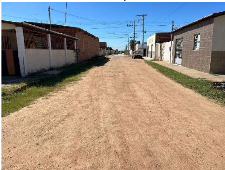
FOTO 05 – Rua 06 Quadra S17-Trecho 02
