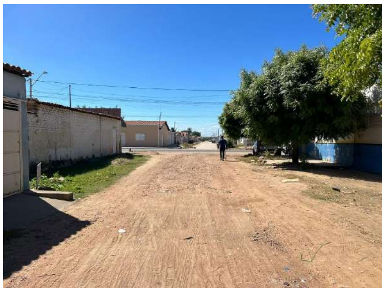
FOTO 02 – Rua 08 Quadra S17-Trecho 02
