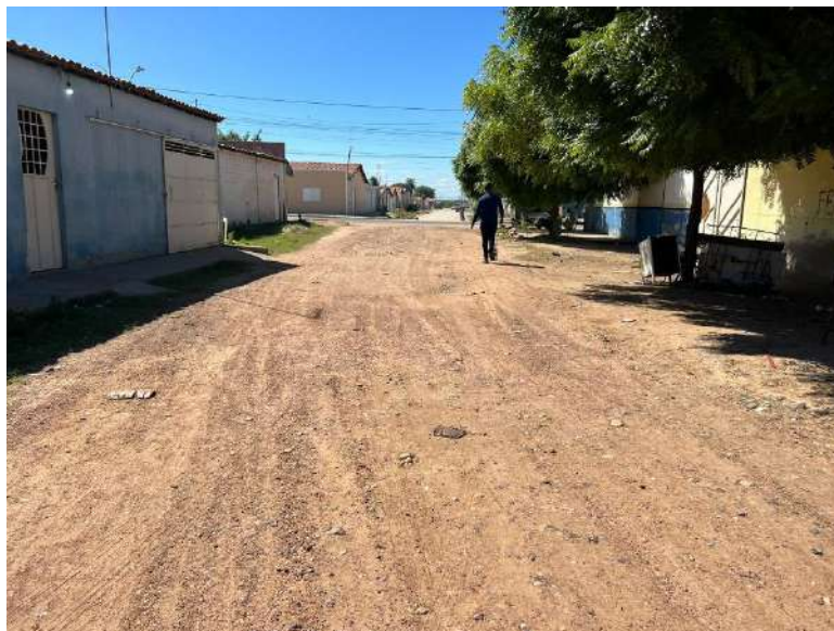
FOTO 01 – Rua 08 Quadra S17-Trecho 02
