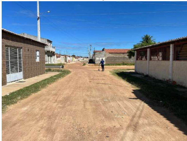
FOTO 02 – Rua 06 Quadra S17-Trecho 02
