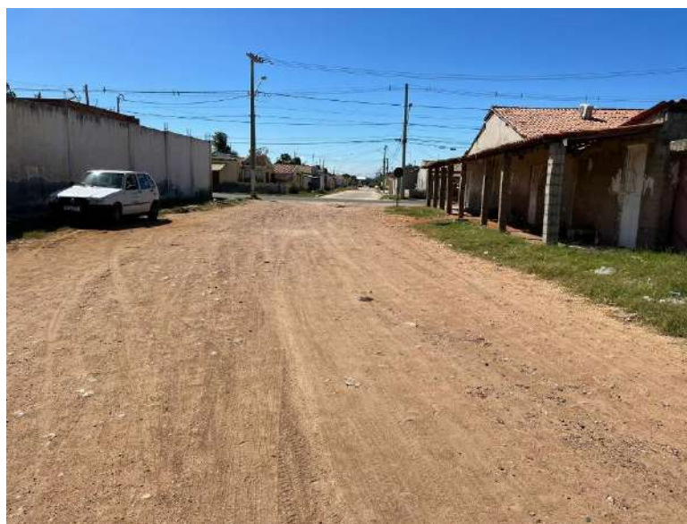
FOTO 03 – Rua 05 Quadra S17-Trecho 02
