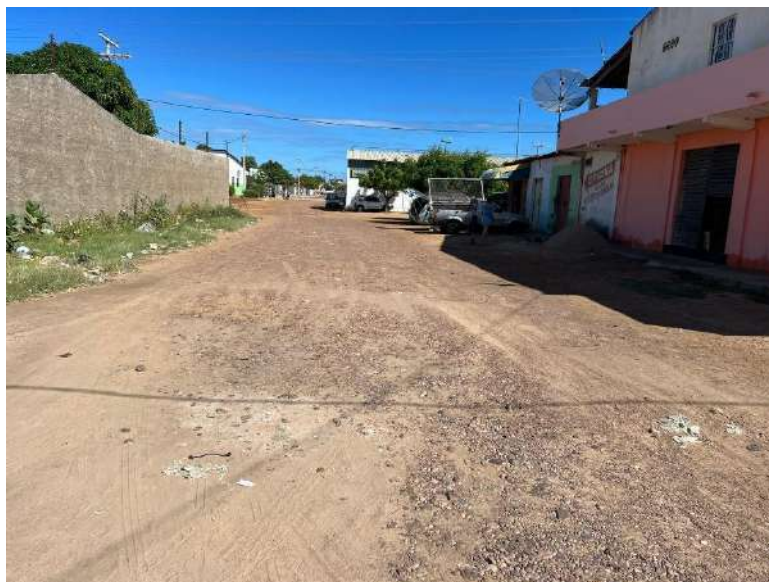
FOTO 01– Rua 02 Quadra S17-Trecho 02
