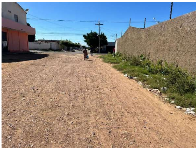
FOTO 03 – Rua 02 Quadra S17-Trecho 02
