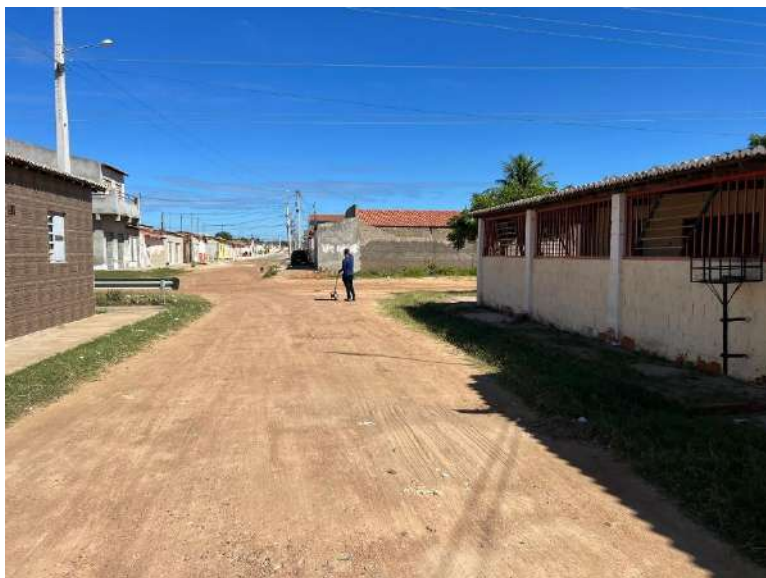
FOTO 04 – Rua 06 Quadra S17-Trecho 02
